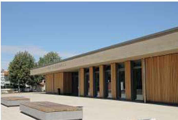
Die neue Rheingießehalle in Rust wurde im September 2020 offiziell eröffnet. Foto: Gemeinde
